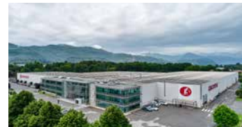
Giacomini S.p.A. Plastic material plant San Maurizio d'Opaglio (NO) (G2)
