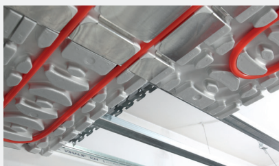
Монтаж і встановлення панелей і труб R883-1 уздовж попередньо сформованих панелей і корпусів головок
