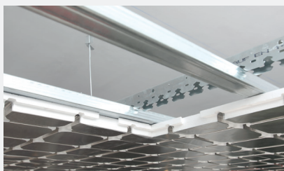
Монтаж металоконструкцій з кроком 300 мм
