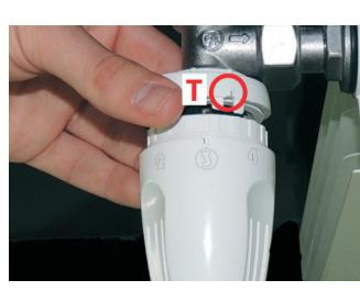
Поверните ограничительное кольцо. При помощи контрольной метки «T» (см. рис.), которая служит ориентиром для правильного совмещения деталей, присоедините ограничительное кольцо, совмещая его с одной из трех пиктограмм, нанесенных на заднюю поверхность ручки:
