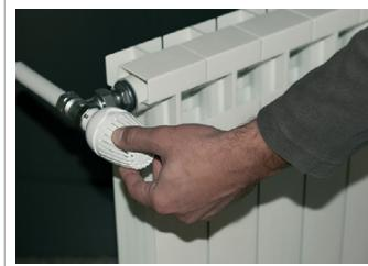
Теперь головка прикреплена к клапану, и с ее помощью можно задать желаемые температурные параметры.
