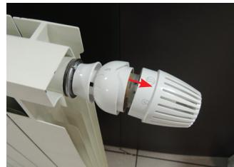
Установить ручку в требуемое положение и снять, потянув вперед.
