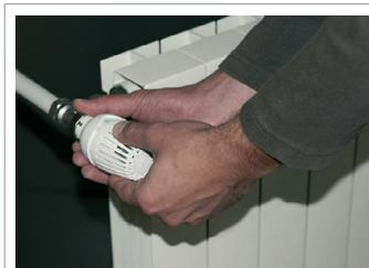
Вставьте термостатическую головку в шестигранное отверстие клапана и завинтите накидную гайку.
