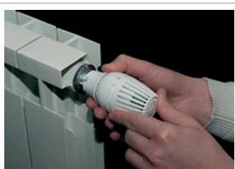
Подсоединить термостатическую головку к клапану, выступ на корпусе клапана (A) должен совпасть с пазом в лепестке цанги (B) и с указательной риской (C) термостатической головки. Выступ нельзя совмещать с прорезью между лепестками цанги.
