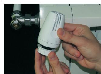
Полностью откройте терmostатическую головку поворотом ручки в положение «**O**».
