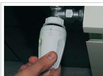
Теперь терmostатическая головка прикреплена к клапану, и поворотом ручки-регулятора можно задать желаемые температурные параметры.
