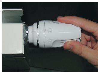
Установить желаемые температурные параметры, вращением ручки термоголовки.
