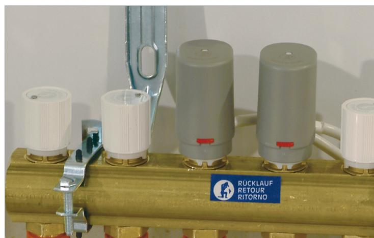
Рисунок 9. Электротермические сервоприводы, установленные на коллектор.
