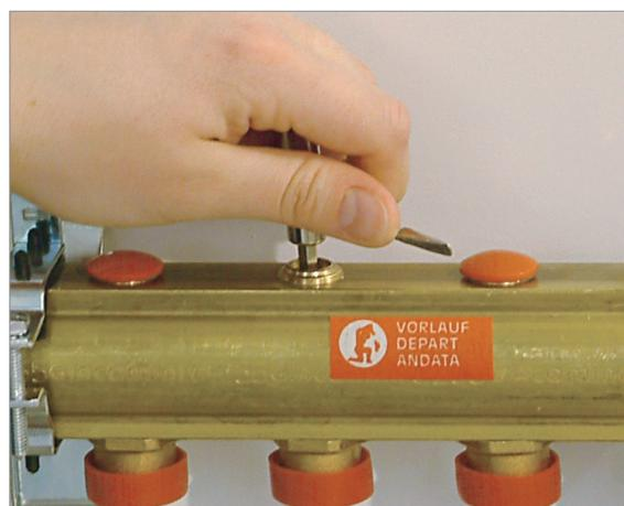
Рисунок 3. Балансировка контуров
