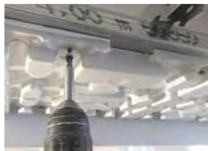
Установка и крепеж панелей на металлический каркас направляющих винтами 35 мм
