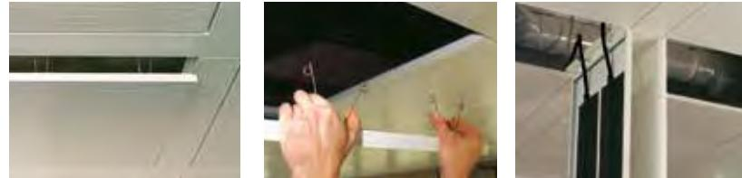
Панель закреплена предохранительными пружинами, и после отстегивания ее можно поместить вертикально.
