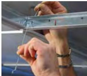
1. Металлические подвески PGK устанавливаются в соответствующие опорные отверстия
