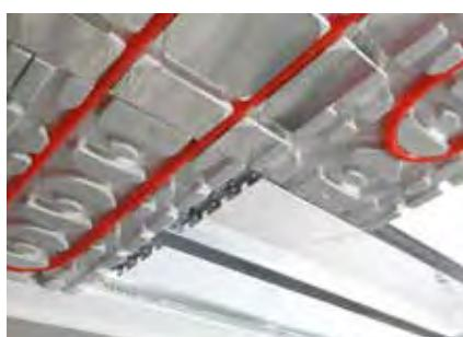
Установка панелей R883-1 и крепеж труб вдоль предварительно отформованной панели основного помещения
