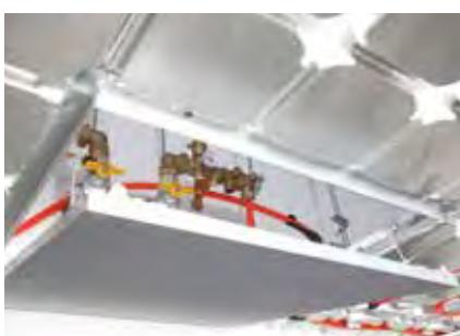
Установка инспекционного люка на место монтажа распределительных коллекторов
