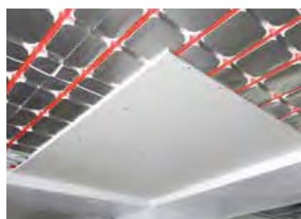
Установка и монтаж листов гипсокартона на направляющей структуре после испытания давлением в соответствии с действующими правилами
