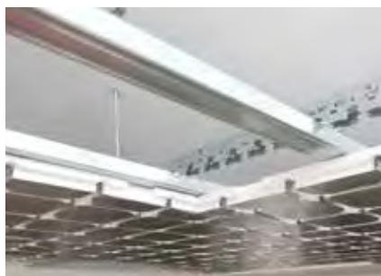
Монтаж металлической конструкции с шагом 300 мм
