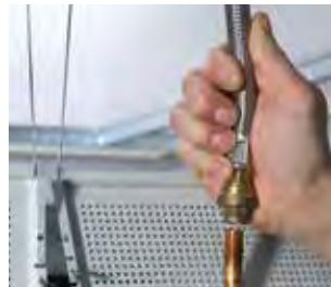
3. Далее следуют подключения к системе отопления/охлаждения: панели, которые являются частью одного контура, соединены друг с другом, а первая и последняя панели контура соединены с распределительным коллектором - один для подающей линии, а другой для обратной.
